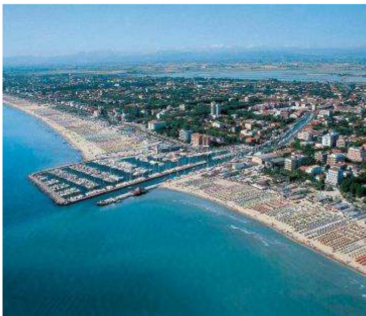
La Arco lavori si aggiudica la progettazione e l'esecuzione dei lavori
